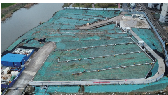
南通东懋化工有限公司地块土壤及地下水修复治理
