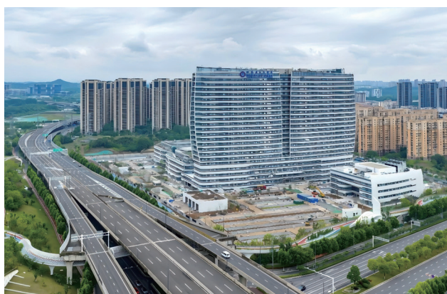
贾东村地块污染土壤及地下水修复治理
