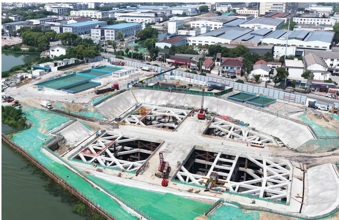
苏州鑫隆化工地块土壤及地下水修复治理
