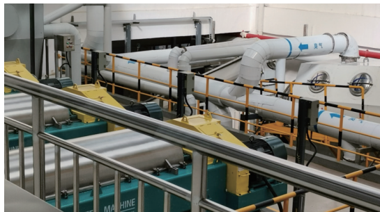
江南生物能源再利用中心
