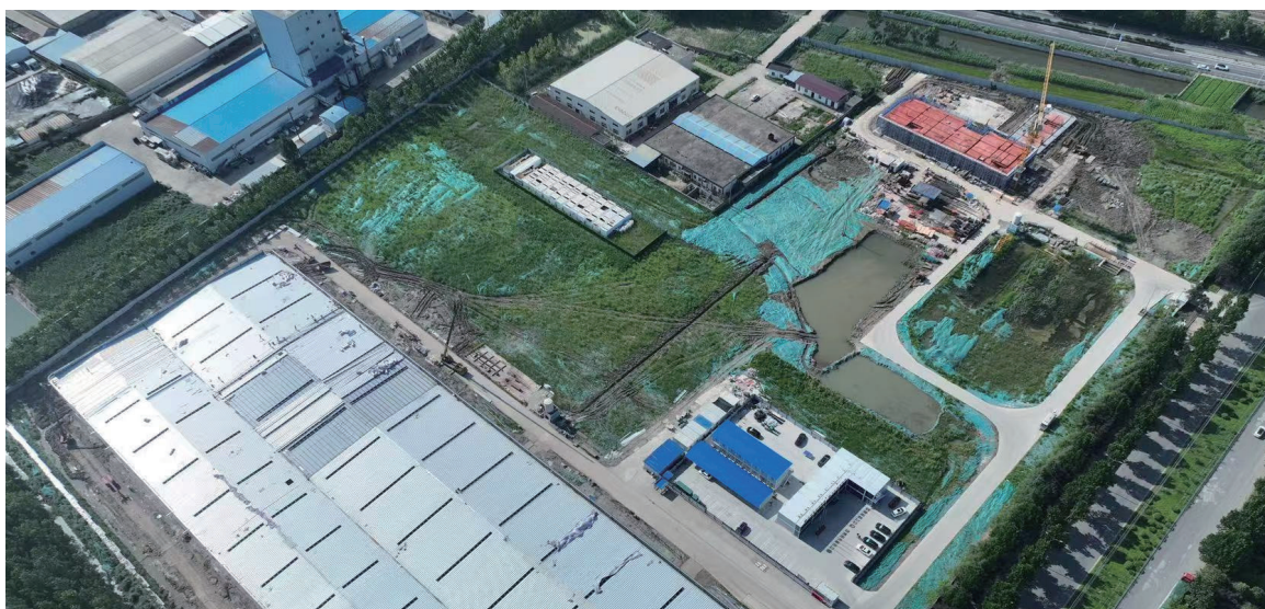
连云港海州区建筑垃圾资源化处置
