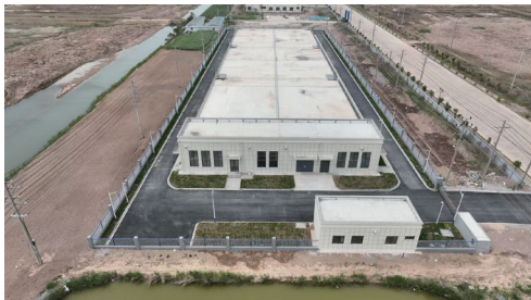
江苏滨海沿海工业园三级防控体系建设工程
