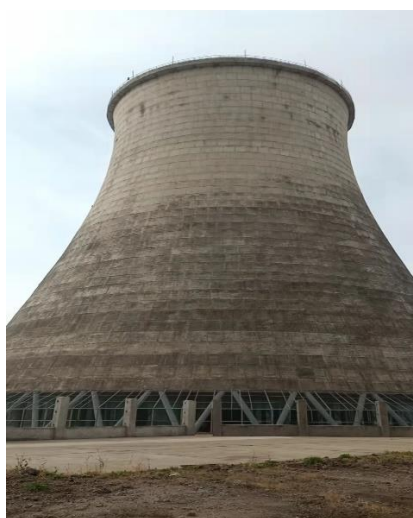
循环水冷却塔
