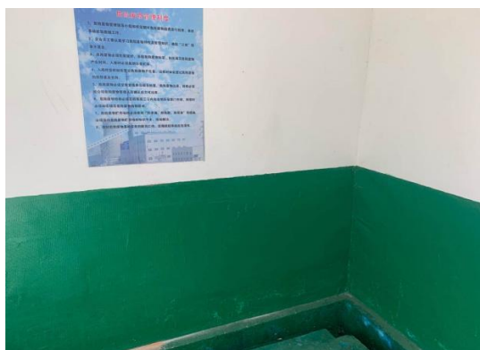
现有危废暂存间内部
