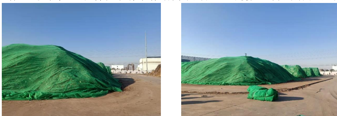
图 4.1-4 堆场燃料防尘网覆盖措施
