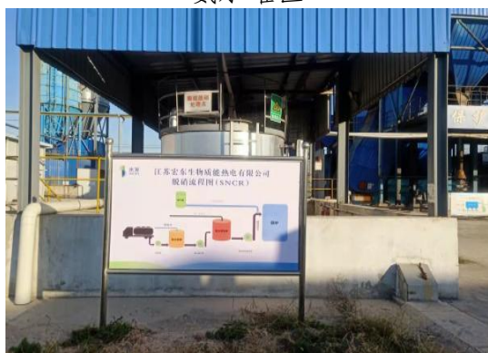
SNCR 脱硝工艺流程
