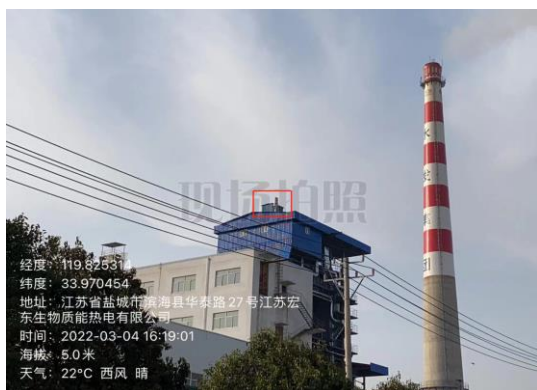
锅炉排汽消音室
