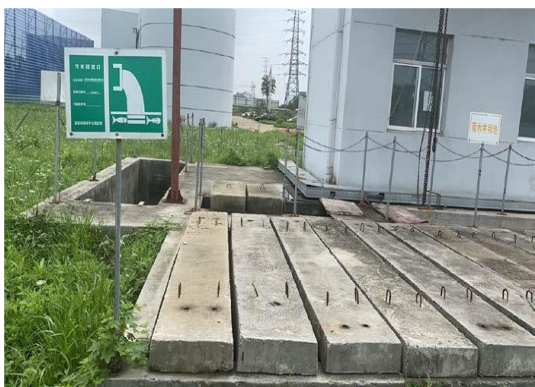
生活污水排放口
