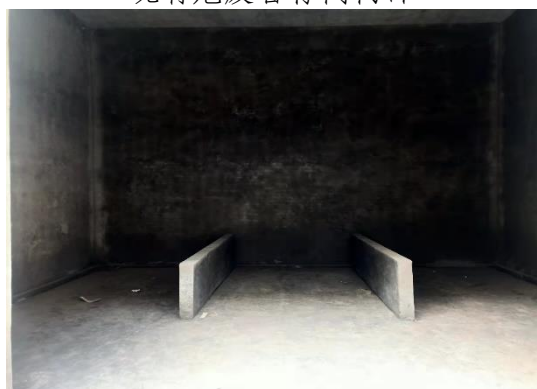
新建危废暂存间内部
