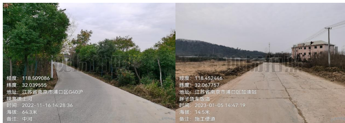
图 4.1-1 施工便道修整情况
